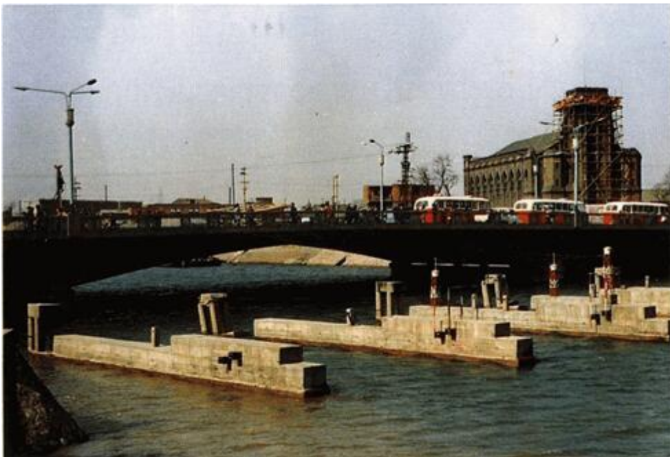
图 4 因地面沉降报废的海河老桥和重建的新桥
